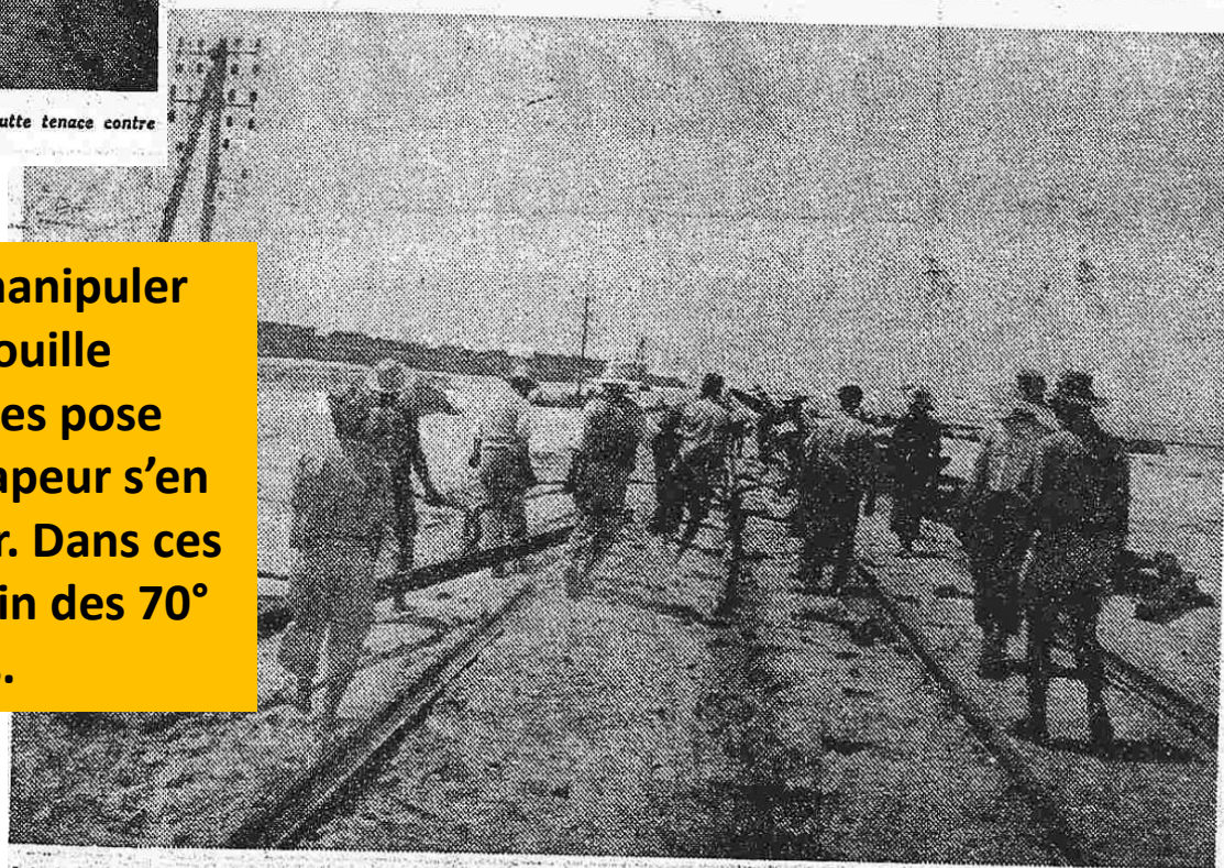
Ici il n'y a pas d'ombre et en plein midi la température atteint des degrés voisins de 60. Les hommes, à l'aide de pinces spéciales transportent sur le ballast de sable un rail. Chaque jour la voie avance de 1 km. 400
