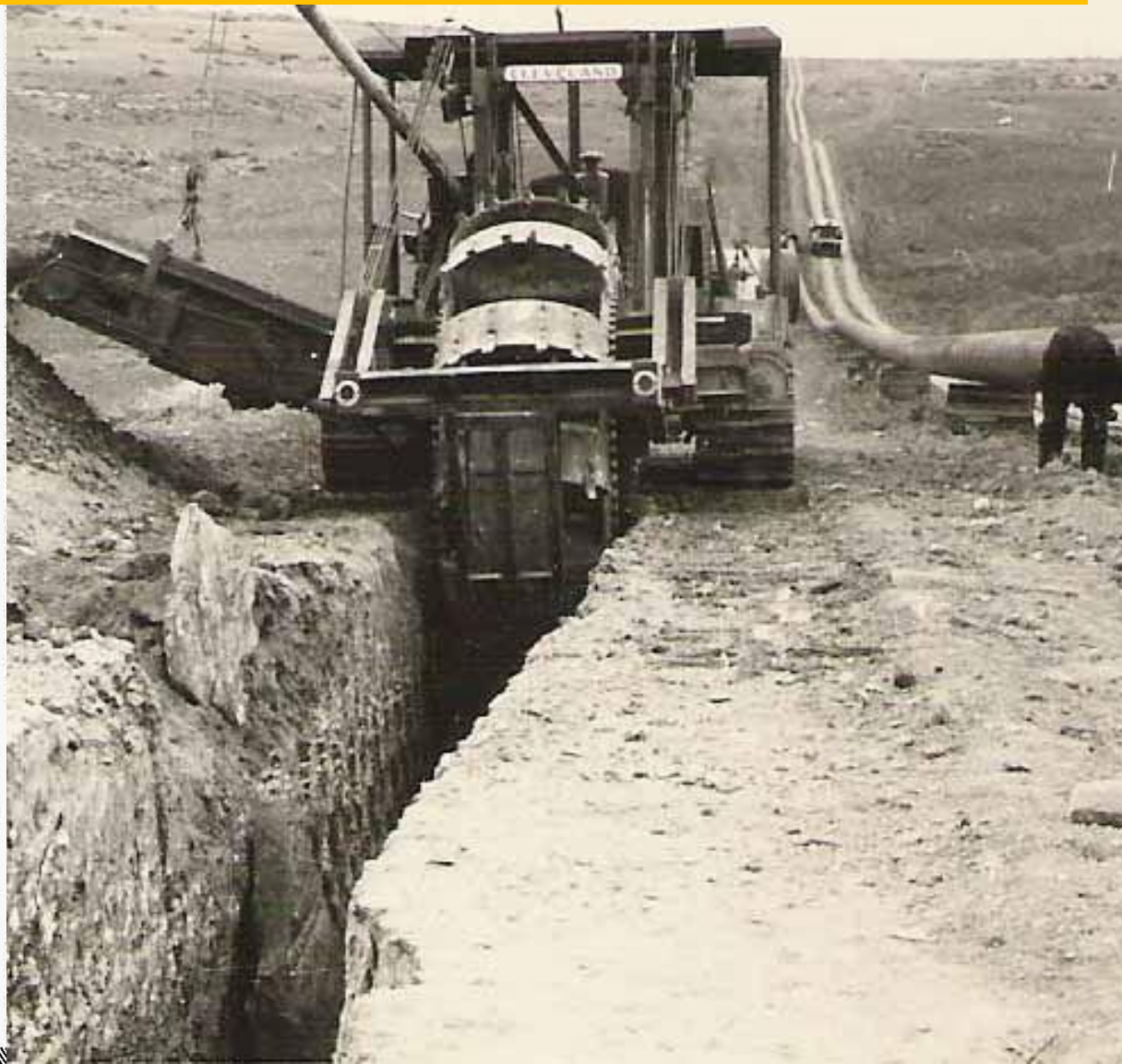
De sa « dent monstrueuse », la trancheuse creuse la tombe de l'oléoduc... (Lire en page 6 la suite du reportage de JEAN TAOUSSON)
