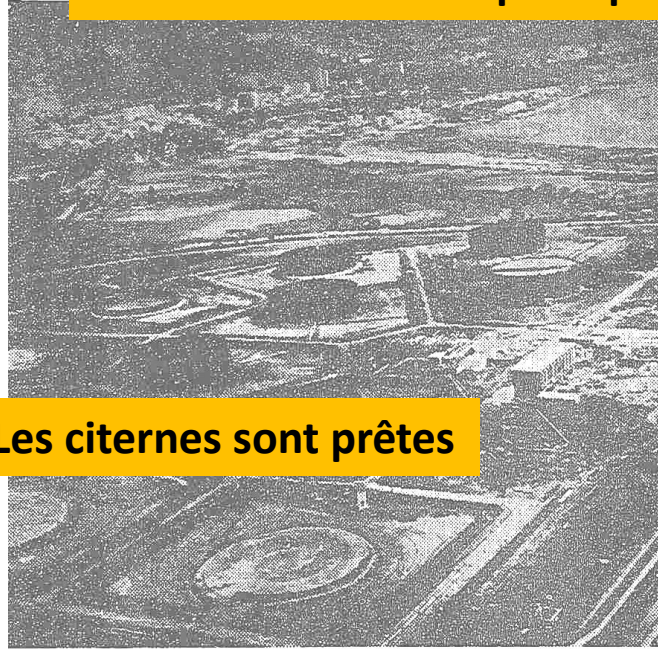
Le Bougie, terminal du grand oléoduc saharien, long de 662 kilomètres, tout est prêt pour Hassi-Messaoud. Sur notre photo, l'immense parc de stockage, aux portes de la ville, qui coûte 6.000 millions de francs. Les citernes sont construites en acier.
